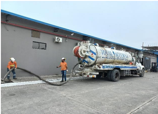
Fotografía 3.- Limpieza de Pozos Sépticos
