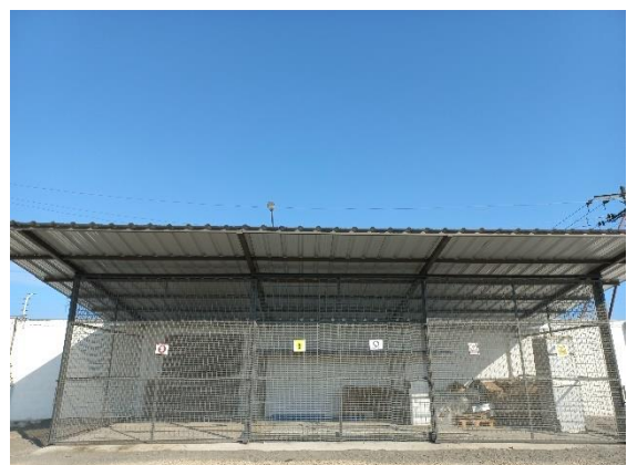
Fotografía 10.- Centro de Acopio
